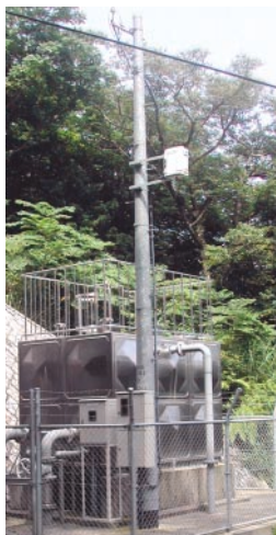
図2 原地区減圧施設
